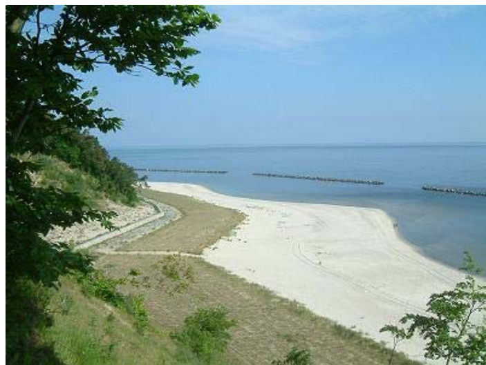
Der neue Schutzverbund – Wellenbrecher, Strandaufspülung, Bepflanzung, Ufermauer & Buhnen (außerhalb des Bildes)
