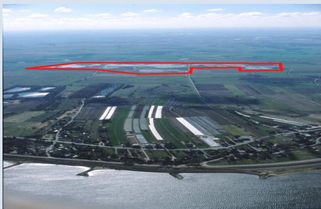
Kleintnahme in der Küstenregion als Maßnahme für Deichbau und Bestandteil abstimmungsbedürftiger Hochwasserschutzplanung. 3
