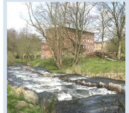
Fischtreppe an der Nebel in Kölln. 1 Die Durchgängigkeit für Fische ist eines der wichtigsten Anliegen der WRRL.
