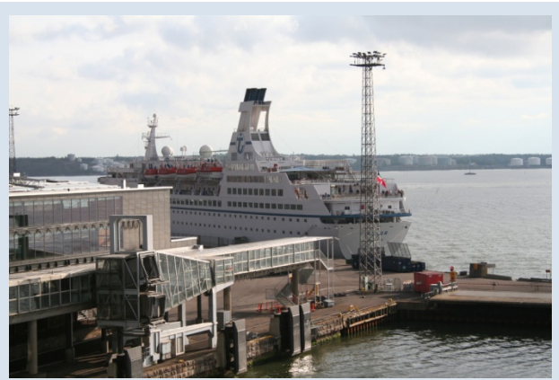
Kreuzfahrttourismus (hier: Terminal in Helsinki) – steigende Nachfrage wirft neue Probleme auf (Erweiterung von Infrastruktur)
